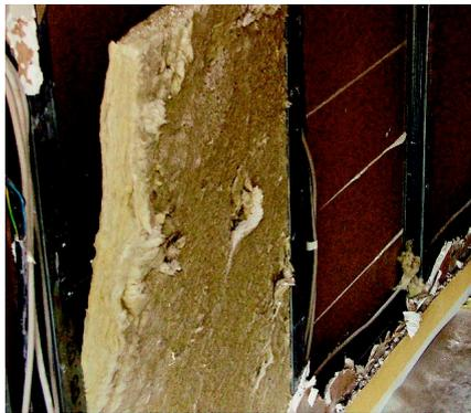
**Mit Schimmelpilz befallene Dämmungen und auch der Gipskarton müssen rückgebaut werden.**
