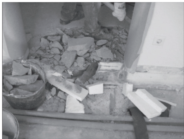
Bild 1: Desinfektion von Estrichdämmungen erspart teuren Rückbau
